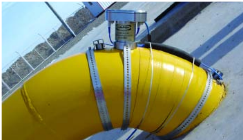
Установка контрольно-управляющего устройства для отслеживания коррозии/эрозии ClampOn на месте эксплуатации
