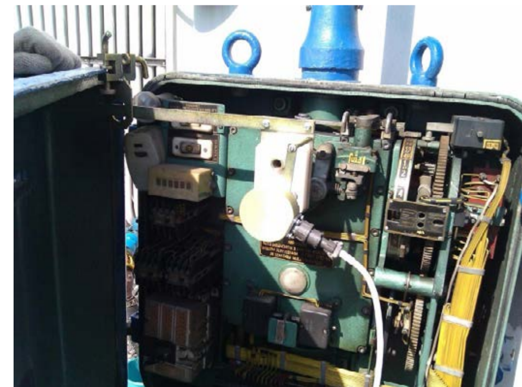
Рис.3. Установка датчика на привод
