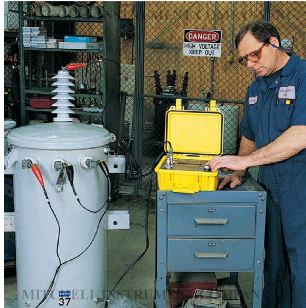
Использование прибора на объекте
