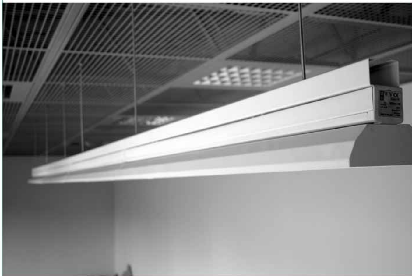
Пример монтажа отражателя ODL, светильника и шины отражателя SOD
