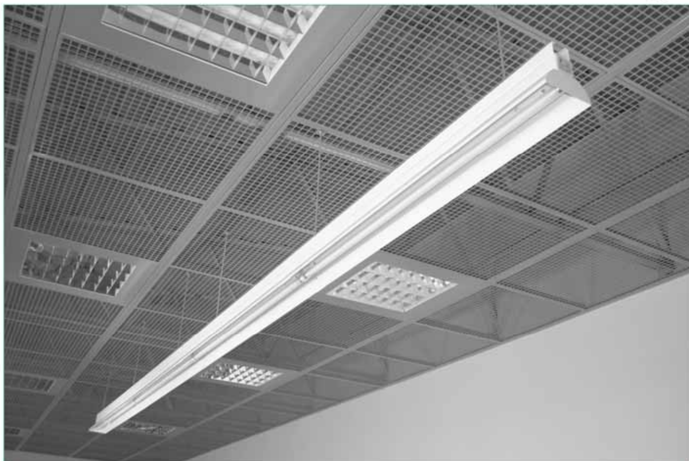
Пример монтажа отражателя ODL, светильника и шины отражателя SOD
