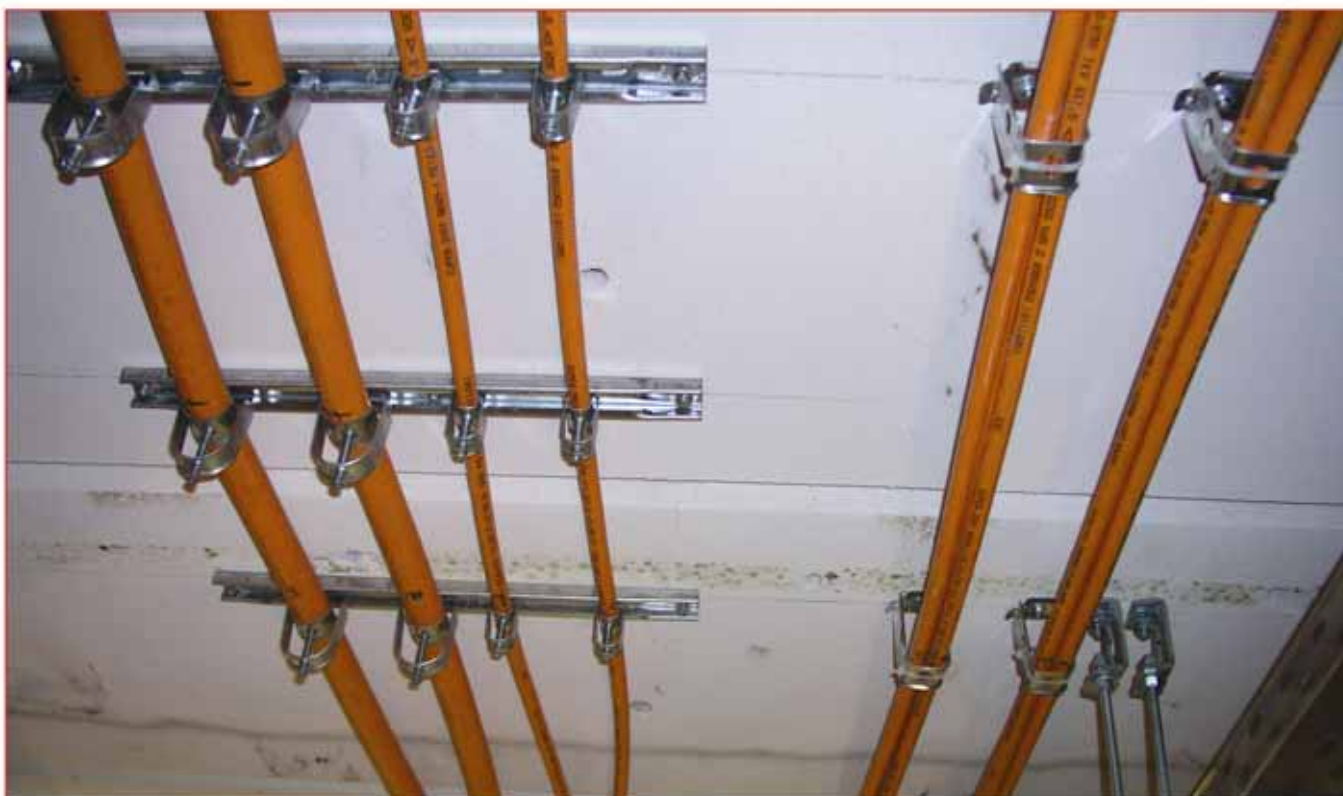
Примеры конструкции системы E-90
