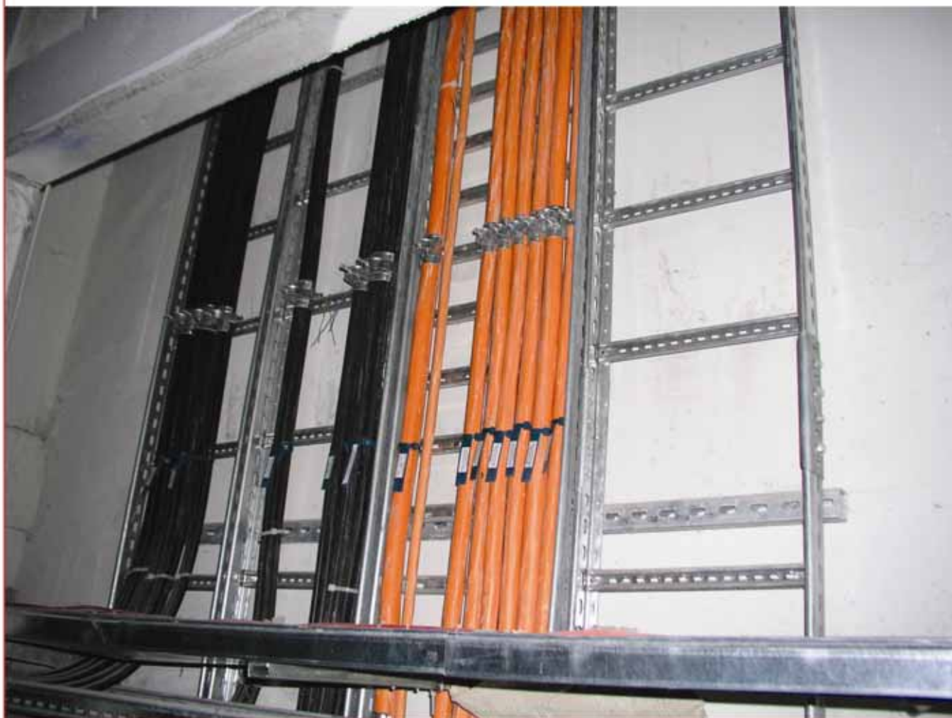
Примеры конструкции системы E-90
