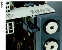
Блокировка вкатывания при открытой дверце
