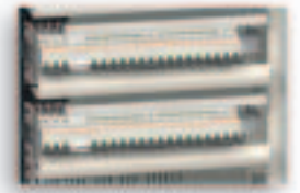
Пример подключения посредством гребёчатых шинок
