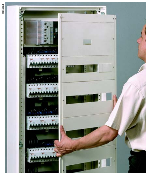
Съёмная передняя панель обеспечивает удобный доступ к коммутационной аппаратуре
