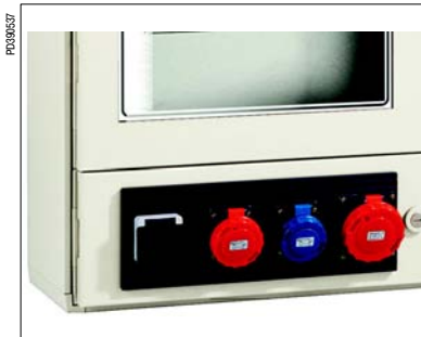
Установка розеток на малой двери
