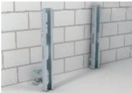
Монтаж стойки подведения питания к электрооборудованию с помощью крепёжной скобы
