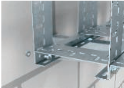
Монтаж напольного профиля в систему ВКК.
