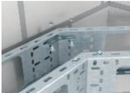
Простое создание поворотов с помощью шарнирных соединителей типа SV. Боковые стенки подлежат обрезке.
