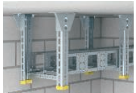
Пример монтажа U-образной стойки с поперечным профилем и модульной системой.
