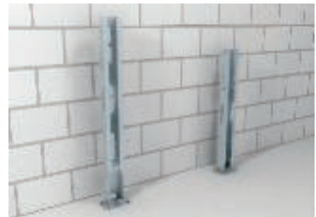
Монтаж стойки подведения питания к электрооборудованию с помощью основания стойки
