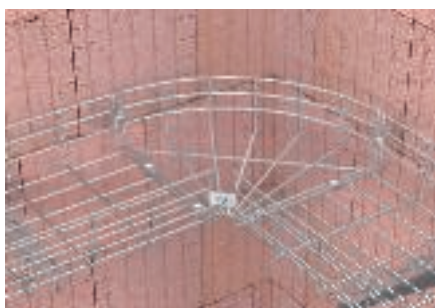
Монтаж угловой секции проволочного лотка
