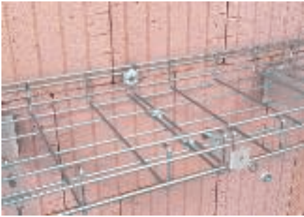
Продольное соединение С-образного проволочного лотка
