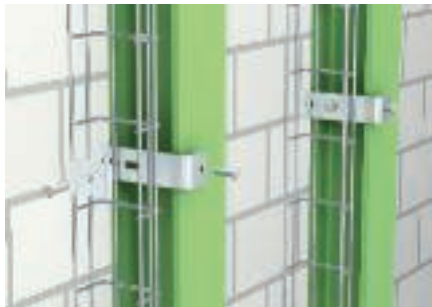
Вертикальный монтаж проволочных лотков
