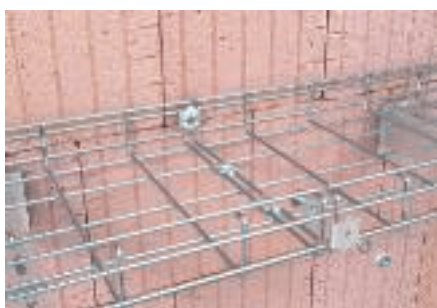
Болтовое продольное соединение проволочных лотков
