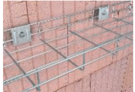
Настенное крепление проволочных лотков
