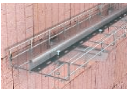
Крепление разделительных полочек в проволочных лотках
