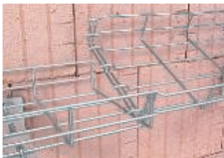
Продольное соединение проволочного лотка Magic
