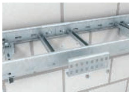
Продольное соединение кабельных лотков лестничного типа с помощью продольного соединителя типа LVG.
