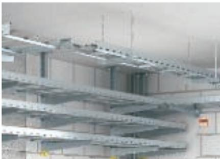
Пример монтажа кабельных лотков лестничного типа с подвесками из U-профилей и резьбового стержня.
