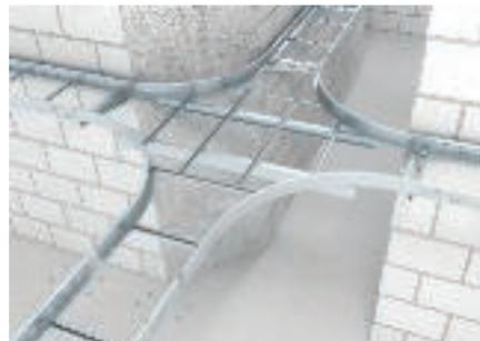
Монтаж крестообразной секции типа LK для создания двух углов. Для обеспечения стабильности конструкции в области фасонных деталей рекомендуется установить дополнительные опоры.
