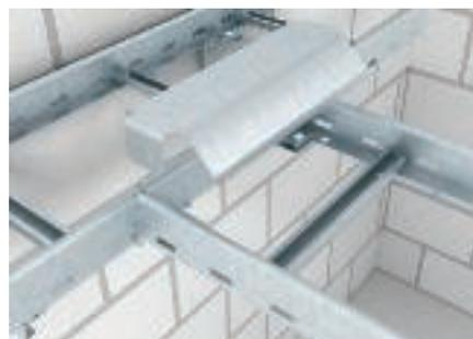
Т-соединение кабельных лотков лестничного типа, смонтированных на одинаковой высоте. Для увеличения площади опорной поверхности кабеля и для защиты кабеля применяются опорные пластины типа LALB. В области углов рекомендуется предусмотреть дополнительную опору.
