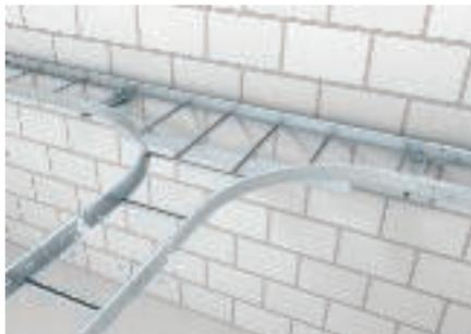
Монтаж Т-образной секции типа LT. Для обеспечения стабильности конструкции в области фасонных деталей рекомендуется установить дополнительные опоры.
