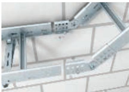
Монтаж вертикального соединения углов с помощью шарнирных соединителей типа LGVG.
