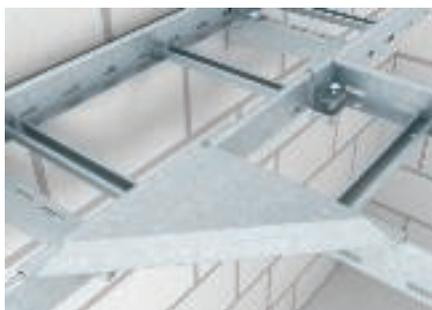
Т-соединение кабельных лотков лестничного типа, смонтированных на одинаковой высоте. Для увеличения площади опорной поверхности кабеля и для защиты кабеля применяются угловые листы типа LEB. Для обеспечения стабильности конструкции в области углов рекомендуется установить дополнительные опоры.
