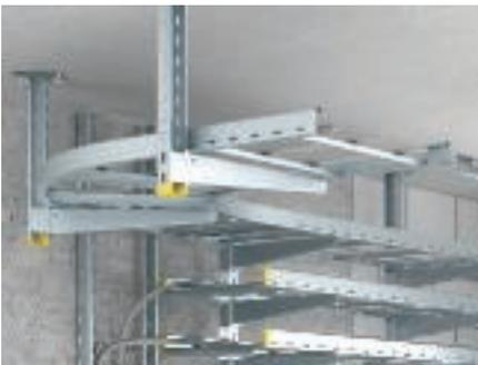
Изображение готового монтажа кабельного лотка лестничного типа.
