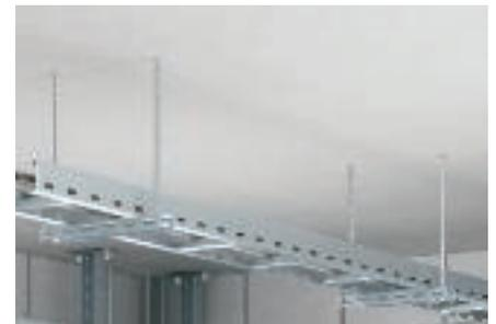
Крепление кабельного лотка лестничного типа со стержнями с резьбой и U-образными стойками из поперечного профиля.
