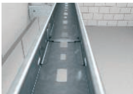
Продольное соединение кабельных лотков для монтажа светильников
