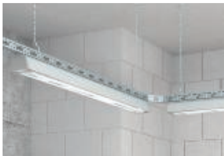
Применение усиленных кабельных лотков для монтажа светильников
