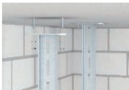
Монтаж I-образной подвесной стойки
