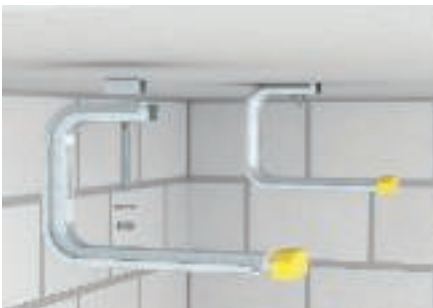
Монтаж настенной / потолочной скобы ТР на потолке
