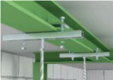
Стальной фиксатор С-образной профильной рейки
