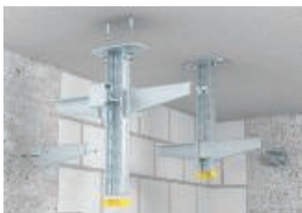
Стандартный монтаж U-образных подвесок US 3 К, US 5 К и US 7 К на потолке и прямой настенный монтаж настенных и потолочных кронштейнов.
