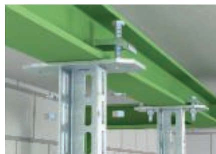
Крепёж с помощью фиксаторов подвесок на стальных конструкциях.
