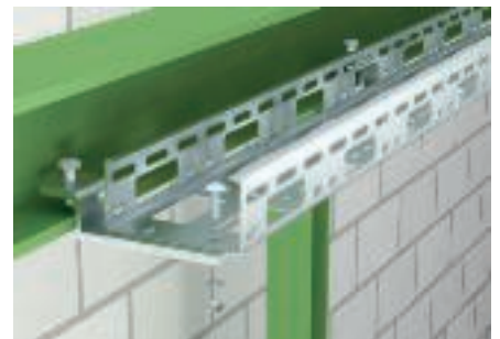
Крепёж с помощью фиксаторов, горизонтальный
