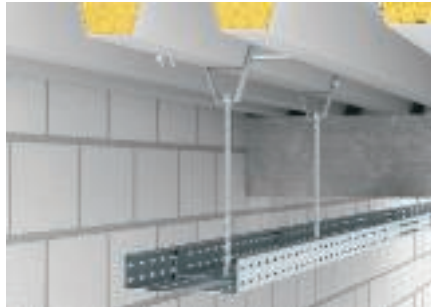
Монтаж трапециевидной подвески
