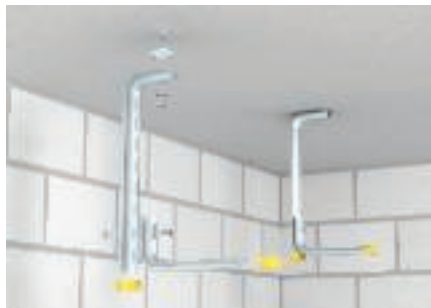
Монтаж подвесной стойки ТР с односторонним монтажом кронштейна.
