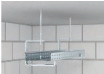
Подвес резьбового стержня с подвесной скобой
