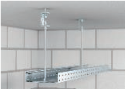
Монтаж центрального потолочного подвеса
