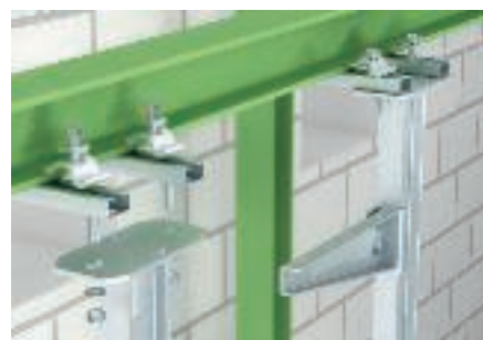
Стальной фиксатор C-образного профиля, трасса в поперечном направлении
