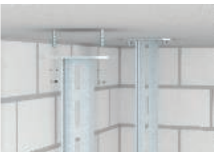
Стандартный монтаж подвесок на бетонном потолке с помощью анкерного болта типа FAZ II.
