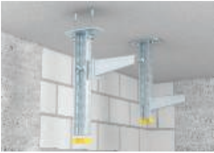
Стандартный монтаж подвесной стойки с настенным кронштейном без распорки
