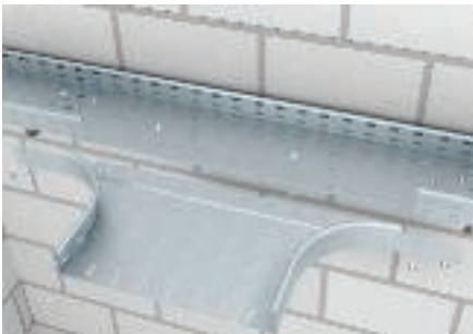
Монтаж Т-образного / крестового соединения (ширина 400 - 600 мм)
