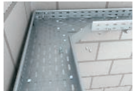
Угловой соединитель как элемент поворота
