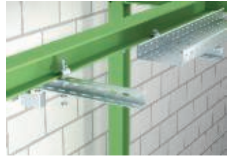
Монтаж кабельных лотков на стальной конструкции
