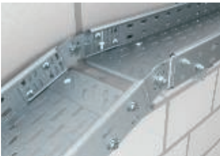
Шарнирное соединение кабельных лотков
