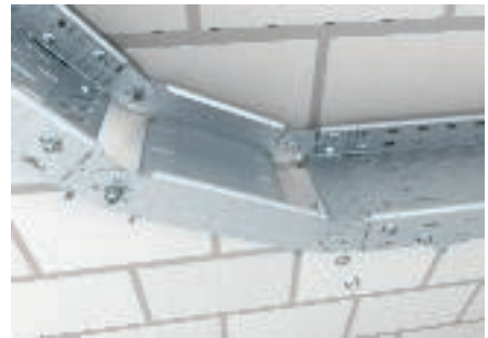
Монтаж элемента вертикального регулируемого угла
