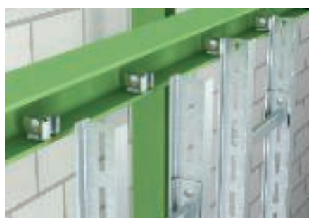
Крепление к стальным конструкциям
