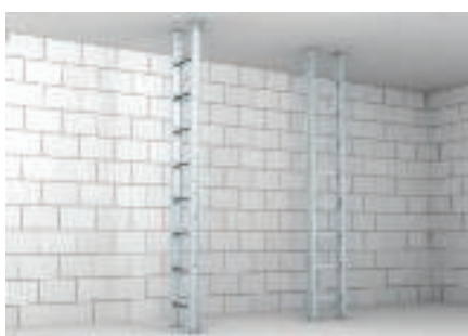
Монтаж вертикального кабельного лотка лестничного типа
