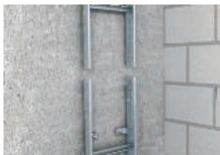
Продольное соединение кабельных лотков лестничного типа
