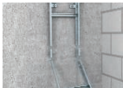
Шарнирное соединение кабельных лотков лестничного типа
