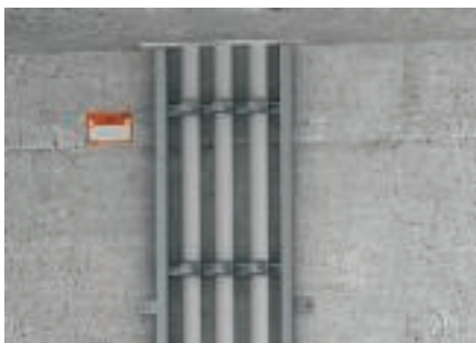
Настенный монтаж кабельных лотков лестничного типа с помощью крепёжных углов.
