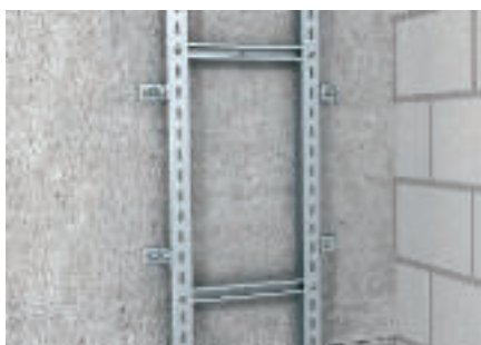
Крепление кабельных лотков лестничного типа к стене
