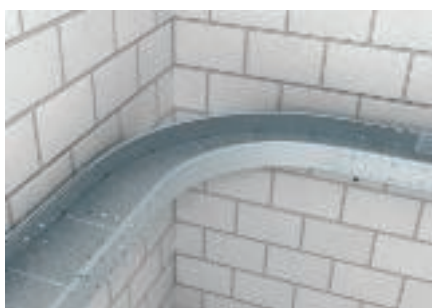
Монтаж угловой секции 90°
