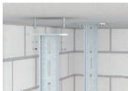
Подвесная конструкция / бетон
