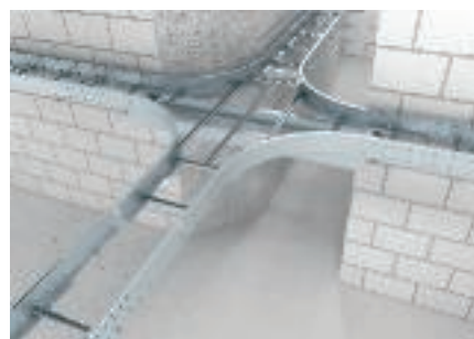
Монтаж крестообразной секции
