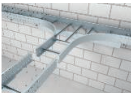
Монтаж Т-образной секции
