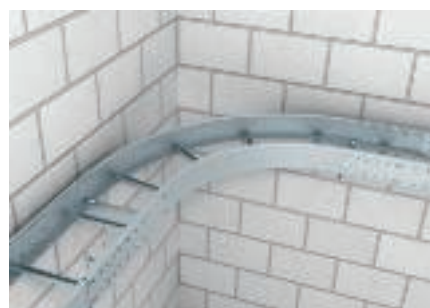
Монтаж угловой секции 90°
