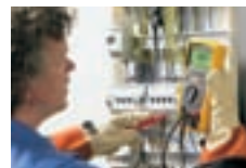
Проверка изоляции в распределительном щите
