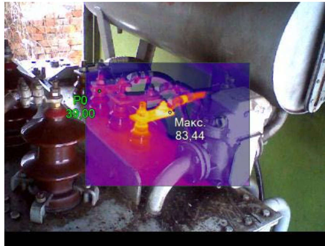
Рис. 5. Дефектное соединение на одной из фаз имеет перегрев 44,4 °С. Следует обратить внимание, что на данном изображении ИК изображение частично прозрачное (наложение 75%), что позволяет оператору ясно видеть компоненты с более низкими температурами.
