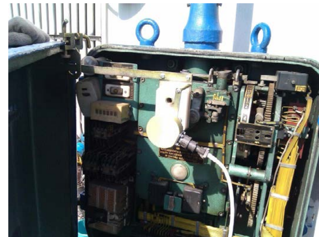
Рис.3. Установка датчика на привод
