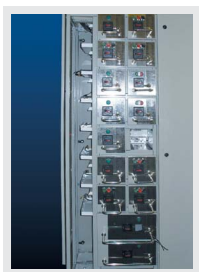
••• Рис. 8.3. Шкаф линейный (ШЛ) с модулями «ELM»
