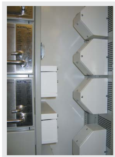
••• Рис. 7.6. Шкаф кабельных подключений для модулей «ELM»
