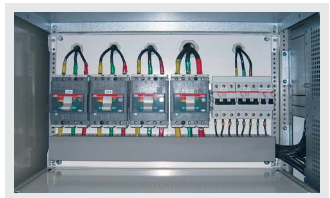
••• Рис. 8.5 Монтажная плата с оборудованием фиксированного УМ
