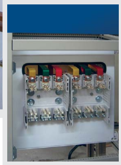
••• Рис. 7.3. Выключатели нагрузки в составе ШЛ
