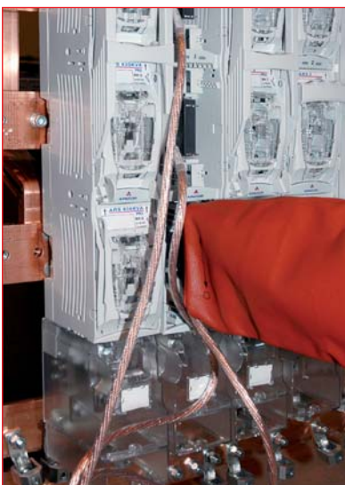
uziemiaenie rozłącznika
