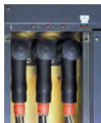
Dubbel anslutning: Material som behövs för 3 faser: 1xRSTI-58xx (sats), 1xRSTI-CC58xx (kopplingsanslutnings- sats)
