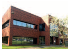
FLIR Systems, Портленд
