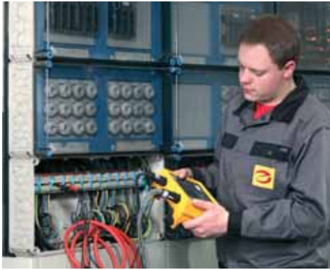
Energieverteiler bis 630 A als Energie-Schaltgerätekombination (PSC) nach DIN EN 61 439 teil 1 und Teil 2
