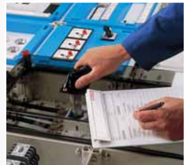
1.1 Prüfung der Funktionstüchtigkeit von Betätigungselementen: z.B. Taster, Schalterantriebe, Türen, Klappen
