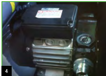
4. Automatic-manual fuel transfer pump / Bomba trasiego para combustible manual y automática / Pompe á main de transfert du combustible, pompe automatique du transfert du combustible.
