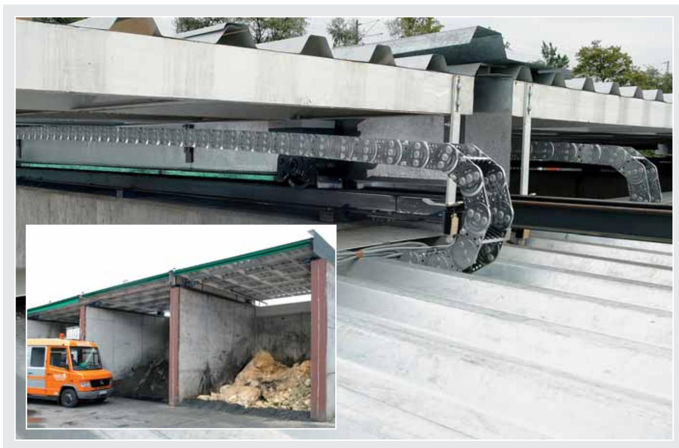
Energieführungsketten aus Stahl an einer verfahrbaren Dachkonstruktion. Fotos: Lindenschmidt KG
