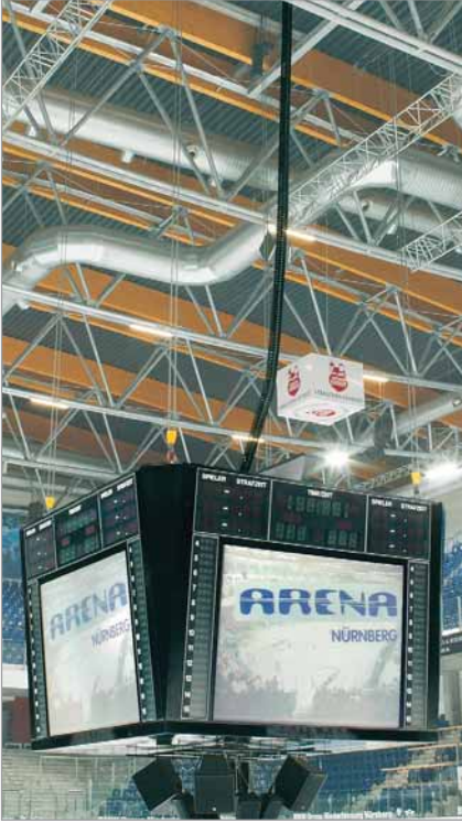
Energieführung UNIFLEX in Zick-Zack-Ablage am absenkbaren Multimediawürfel in der Arena – Nürnberg
