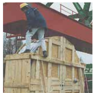
■ Montage der konfektionierten Energieführung
