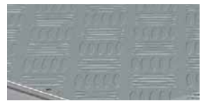
5 Strukturbleche für Rutschfestigkeit (am größten Kasten)
