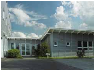
■ KABELSCHLEPP Service-Center Hünsborn
