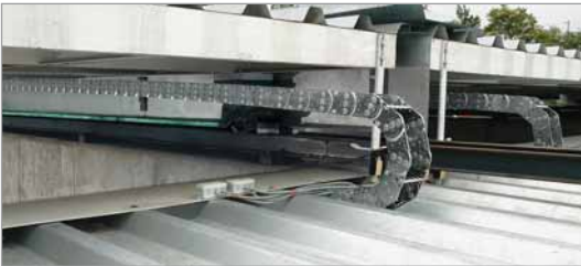
Energieführungsketten aus Stahl an einer verfahrbaren Dachkonstruktion
