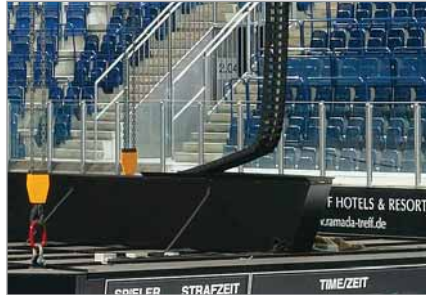
Energieführung UNIFLEX in Zick-Zack-Ablage am absenkbaren Multimediawürfel in der Arena – Nürnberg
