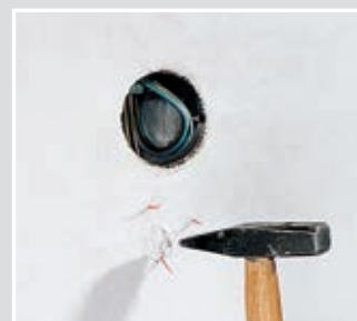
Die genaue Position der Gerätedose zeigen nach dem Verputzen die feinen Markierungsborsten des Signaldeckels an.
