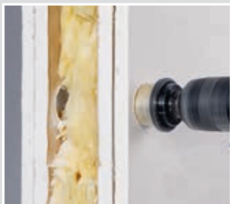
Installationsöffnung \varnothing 35 mm z. B. mit dem KAISER-Fräser Multi 4000 (1082-10) erstellen.
