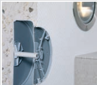
Gehäuse mit Einbausatz vormontieren.
