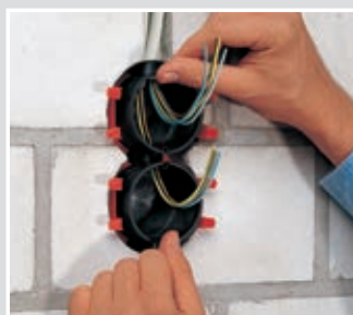
Dose mit aufgerastetem KLEMMFIX® einsetzen.
