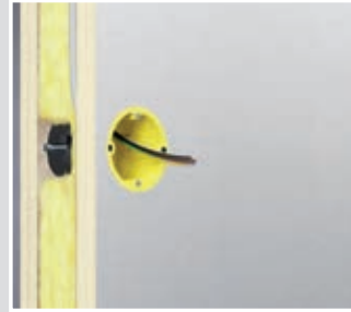
Gegenüberliegender Einsatz der Strahlenschutzdose.
