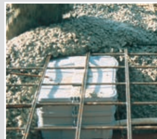
Sicherer und fester Sitz der Gehäuse beim Betonieren.
