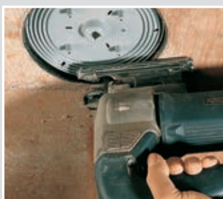
Frontteil mit einer Stichsäge öffnen.
