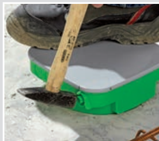
Montage auf der Baustelle: KSK-Technik mit einem Hammerschlag öffnen.
