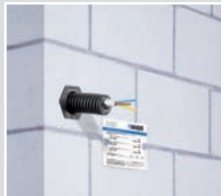
Wanddurchführung durch Brandschutzwand aus Kalksandstein.
