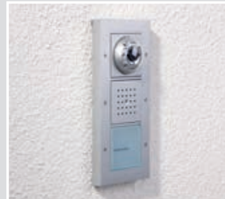
Stabile und wandbündige Installation auch von Mehrfach-Kombinationen.
