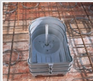
Gehäuse mit 2 Zwischenrahmen und Stützrohr auf der Schalung fixieren.
