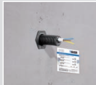
Wanddurchführung durch Brandschutzwand aus Beton.
