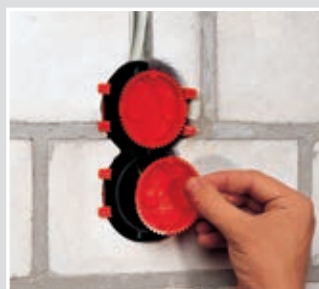
Signaldeckel aufsetzen.
