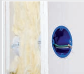
Gegenüberliegender Einsatz der Schallschutzdose.
