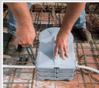
Gehäuse zusätzlich an der Bewehrung sichern.
