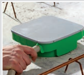
Rohre einführen und fertig betonieren.
