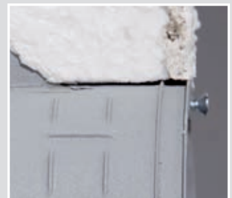
Die umlaufende Dichtlippe dichtet das WDVS ab, so dass keine Feuchtigkeit eindringen kann.
