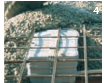
4 Asiento seguro y firme de las carcasas durante el hormigonado.
