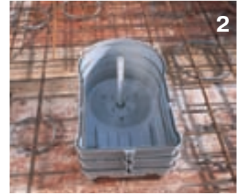
2 Fijar la carcasa con 2 marcos intermedios y el tubo de apoyo en el encofrado.
