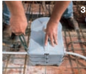
3 Asegurar la carcasa adicionalmente en la armadura.
