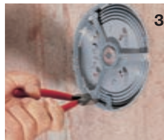
3 Después de desencofrar: retirar los puentes y abrir la pieza frontal.
