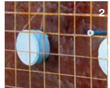
2 Fijación en el encofrado con alambres tensores y clavos.
