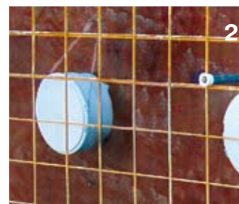
Крепление к опалубке проволоочной стяжкой и гвоздями.
