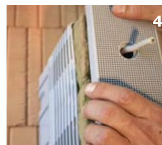
4 Установите монтажную плату (блокировочный зажим внизу) и закройте ее.
