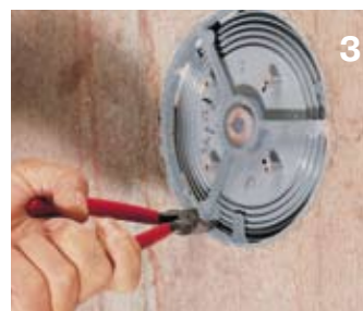
После распалубки: извлеките перемычки и откройте фронтальный элемент.
