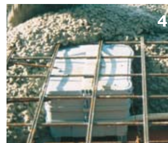
Посадка корпуса с повышенной прочностью и надежностью при бетонировании.
