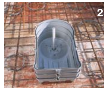
Прикрепите корпус с двумя промежуточными рамками и опорной трубкой к опалубке.
