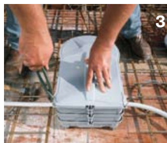
Дополнительно прикрепите корпус к арматуре.
