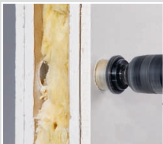
Maak een installatieopening met een diameter van 35 mm bv. met de KAISER-frees Multi 4000 (1082-10).
