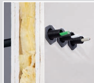
Drie buisdoorvoeringen kunnen met een hartafstand van 50 mm als groep verticaal of horizontaal naast elkaar geplaatst worden.
