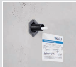
De doorvoeringen kunnen zowel in metselwerk als in betonwanden gebruikt worden.
