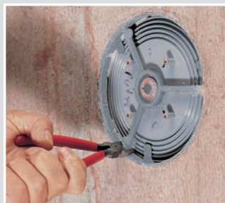
Na het ontkisten: verwijder de binders en open het frontdeel.
