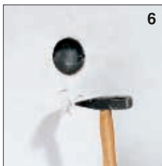
6 Otevření krabice po omítnutí.
