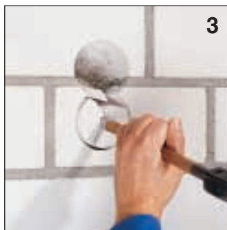
3 Vysekání odvrtného jádra sekáčem.
