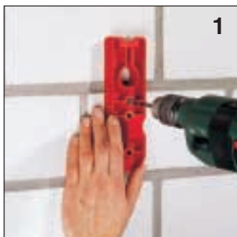
1 Předvrtání, vyvrtání odstupe mezi krabicemi 71 resp. 91 mm s pomocí šablony.
