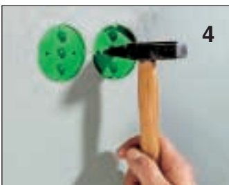
4 Odstraňte zbylé záslepky čelních dílů krabic.
