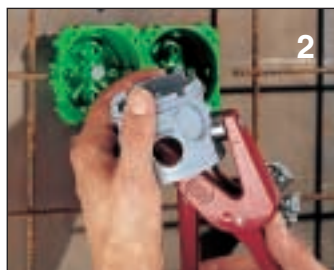
2 Přívod pro kabel nebo trubku zhotovte děrovačem.
