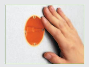
Das Anbohren sollte mit geringen Anpressdruck erfolgen, die weitere Beabeitung ist mit geringem, gleichmäßigem Druck durchzuführen. Pendelbewegungen sind zu vermeiden.
