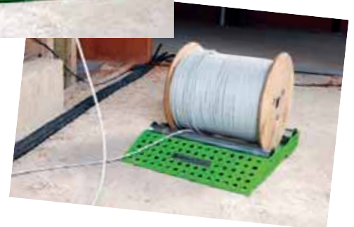
Der Easy Roller vereinfacht das Auf- und Abrollen von Kabeltrommeln.
