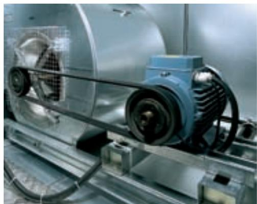
Так как в случаях с насосами, вентиляторами и компрессорами зачастую речь идет об автономных агрегатах, все чаще устанавливаются децентрализованно размещенные преобразователи тока двигателей или устройства плавного пуска двигателя. Их можно устанавливать вместо клеммной коробки на двигателе вне электрошкафа.
