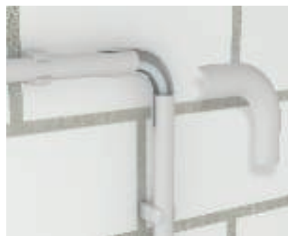
Монтаж дуги Quick-Pipe Дуга насаживается на трубу.
