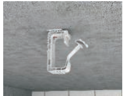
Готовый монтаж, групповое крепление-захват Групповое крепление-захват защелкивается, как только достигается верное положение.
