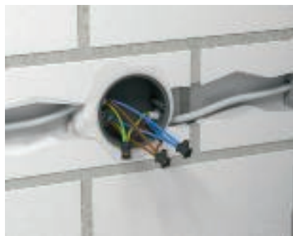
Применение в монтажной коробке для скрытого монтажа С помощью ответвительных клеммных колодок можно соединять несколько проводов в одной клемме.
