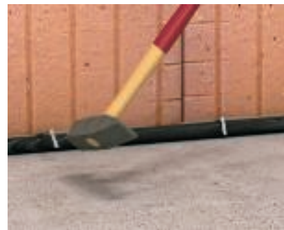
Гвоздь-скоба Гвоздь-скобу забить в монтажное основание. При этом обратить внимание на то, чтобы труба не сильно деформировалась. По этой причине крепление кабелей / проводов гвоздями-скобами подвергается критике.
