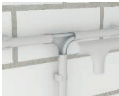
Монтаж Т-образной секции Quick-Pipe Т-образная секция насаживается на трубу.
