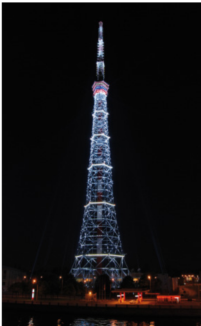
Художественная подсветка с проблесковыми светильниками Quadro R-ST на телебашне в Санкт-Петербурге
