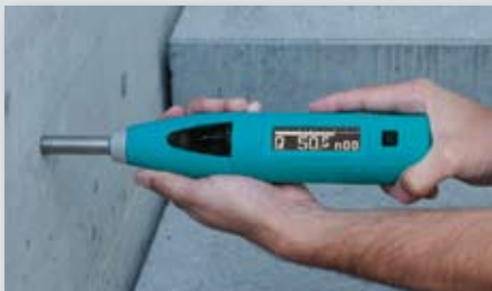
На бетонных стенах, перекрытиях и колоннах
