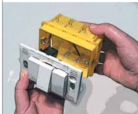
Fig. 5 Fissare il tutto nella scatola 503. Fix everything into box 503.
