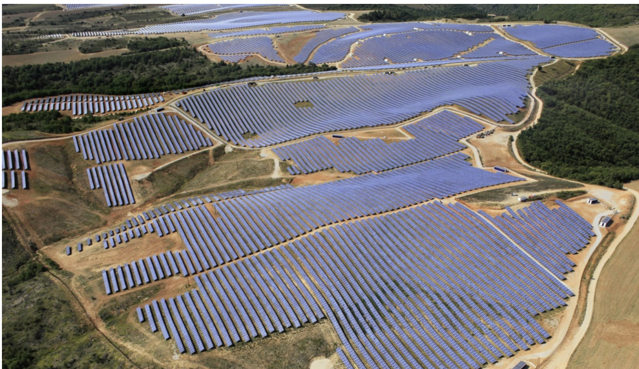
Das 31-MW-Solarkraftwerk Les Mées (Frankreich) wurde 2010/2011 für Eco Delta errichtet und im August 2011 ans Netz angeschlossen. Dabei agierte Siemens mit einem Gesamtkonzept aus einer Hand als Generalunternehmer inklusive Wartungs-, Betriebs- und Garantieleistungen. Bei dem mit 112 400 Solarmodulen auf 66 Hektar installierten PV-Solarpark sind Wechselrichter SINVERT PVS500 im Einsatz. Für die Anlagen-Auslegung wurde die Software SINVERT Select eingesetzt. Die Anlagen-Überwachung wird mit der Software WinCC durchgeführt.
