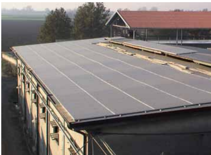
Cortemaggiore (PC) Potenza impianto: 81 kWp EPC Contractor: Renience S.r.l.
