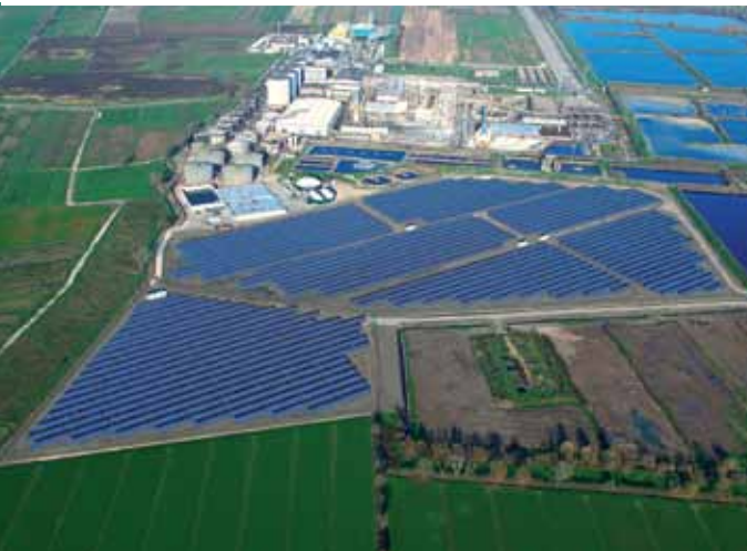
Trecasali (PR) Potenza impianto: 4.500 kWp EPC Contractor: Enerray S.p.A.
