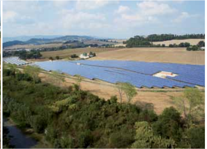
Treia (MC) Potenza impianto: 3.100 kWp EPC Contractor: Siemens S.p.A. - Energy Sector
