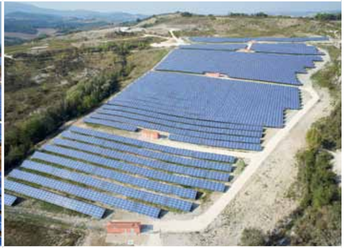
Spoletto (PG) Potenza impianto: 3.300 kWp EPC Contractor: Siemens S.p.A. - Energy Sector
