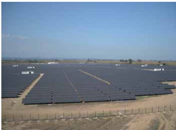
Ciliano (VC) Potenza impianto: 16.000 kWp EPC Contractor: Soland Energia Fotovoltaica S.r.l.
