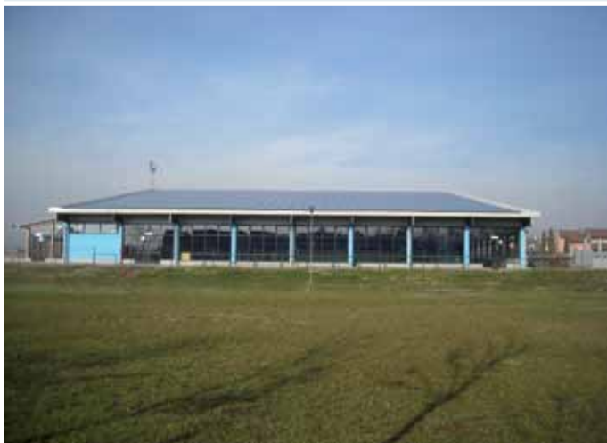
Crescentino (VC) Potenza impianto: 170 kWp EPC Contractor: Soland Energia Fotovoltaica S.r.l.
