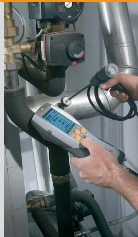
Измерение концентраций дымовых газов на котле
