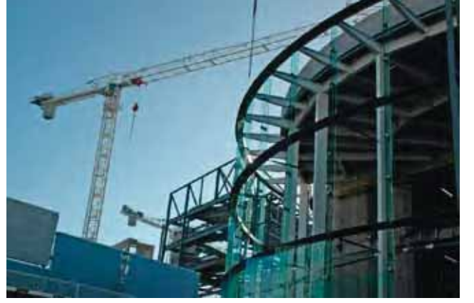
İNŞAAT SEKTÖRÜ CONSTRUCTION FIELD
