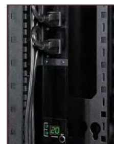
PDU para Instalación Vertical (0U) en Rack
