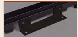
Кронштейн смонтирован снаружи
