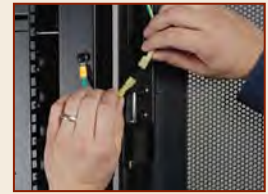
Быстросъемный заземляющий провод
