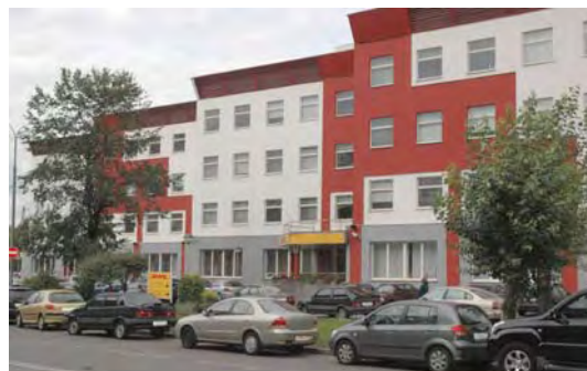
Распределительный центр «DHL-Москва» На улице 8 Марта в Москве
