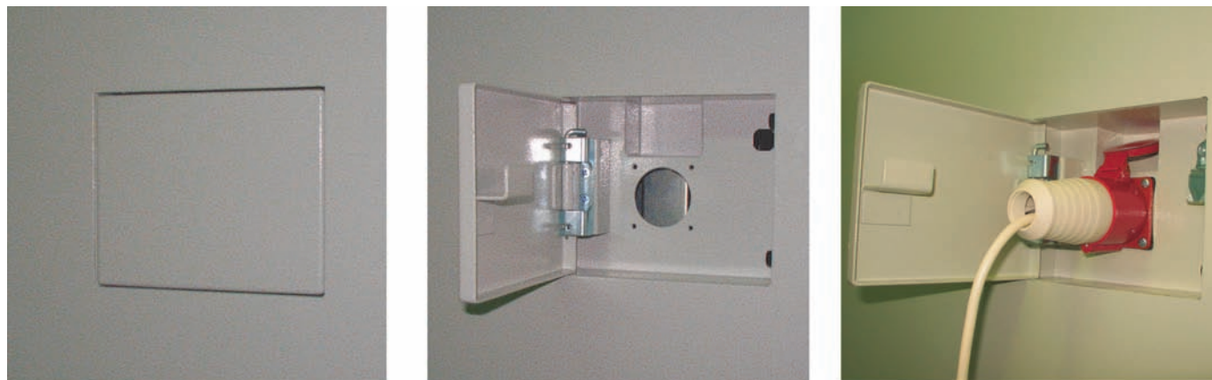
Фото отсека с вилкой для подключения ДГУ
