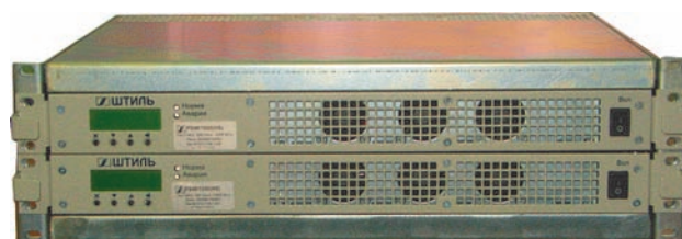
Инвертор Штиль PS48/1500 (STS-HS) в корзине
