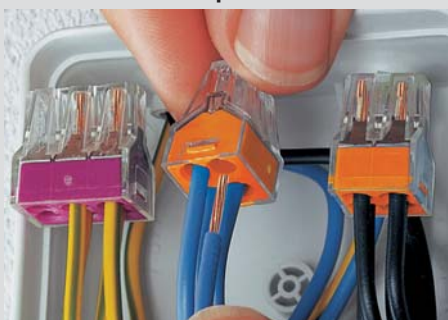
Подсоединение: введите многожильный проводник со снятой изоляцией до упора
