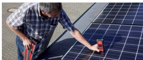
Mit dem „SENSOR“ die Oberflächentemperatur der Module messen.
