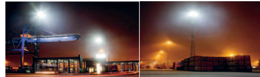
Освещение контейнерного терминала, г. Рига.
