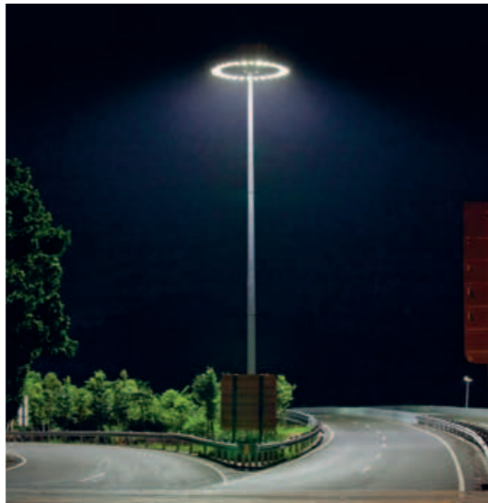
Пример освещения участка скоростной трассы "Цзин Хан Ао" мачтовыми светильниками Shine® HMM 280 Вт с линзой A4 на нескольких опорах. Высота опоры 30 м, количество светильников на опорах — 30 шт., мощность короны — 8,4 кВт, световой поток короны — 756 000 лм.
