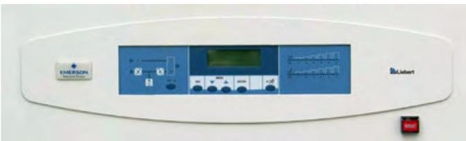
На жидкокристаллическом дисплее показываются данные о входных и выходных параметрах работы ИБП: напряжении, частоте, мощности, напряжении и токе батареи, температуре внутри ИБП и температуре батареи.
